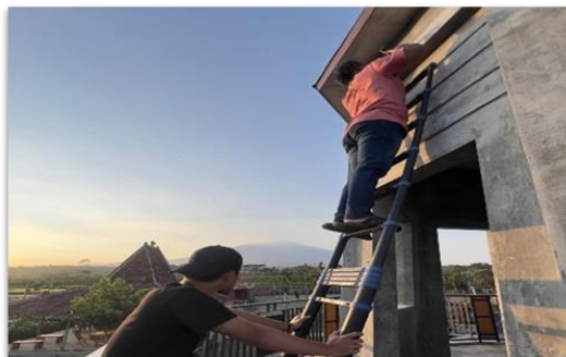
Gambar 1. Proses pemasangan lampu sorot di salah satu titik dikawasan Kedok Ombo.
