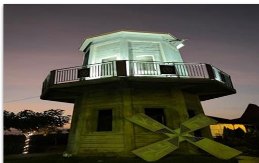
Gambar 2. Hasil Pemasangan lampu Sorot di salah spot di Kawasan wisata Kedok Ombo.
