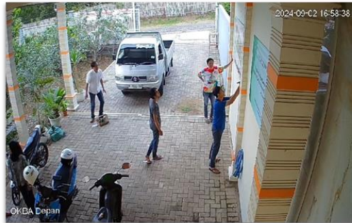
Gambar 4. Proses pemasangan papan peta blok area di OKBA
