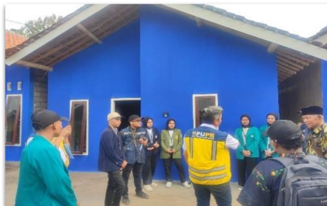
Gambar 5. Pengecekan progress fisik Omah Jejer
