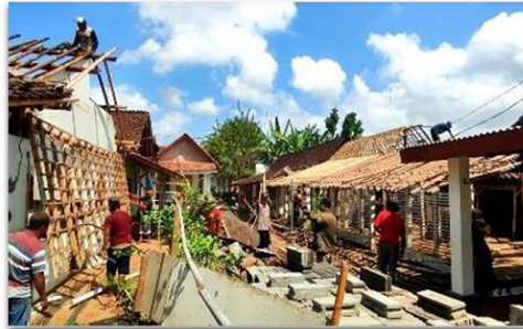
Gambar 4. Pembongkaran rumah "Sambatan"
