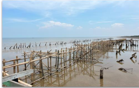
Gambar 4. Pembangunan hybrid engineering
