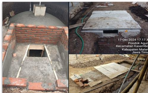
Gambar 2. Pembangunan fisik reaktor biogas
