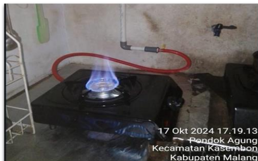
Gambar 3. Hasil penggunaan biogas sebagai pengganti LPG
