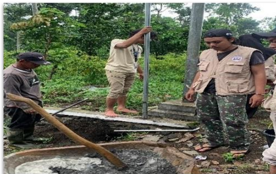
Gambar 6. pemasangan di pertigaan jalan Semeru
