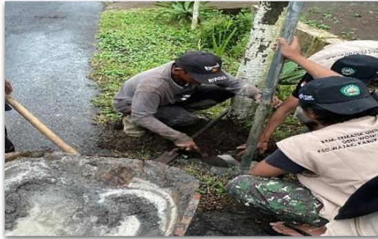
Gambar 5. Pemasangan di pertigaan stadion Wonoayu
