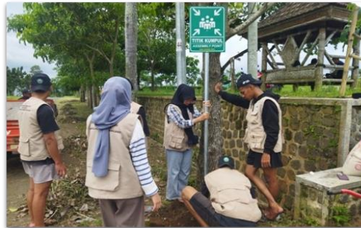
Gambar 2. Pemasangan plang titik kumpul
