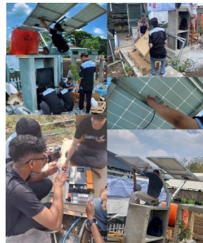
Gambar 6. Pemasangan Panel Surya
