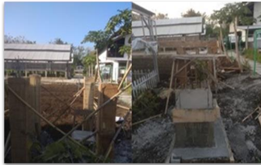
Gambar 5. Pengerjaan pondasi unit PLTS
